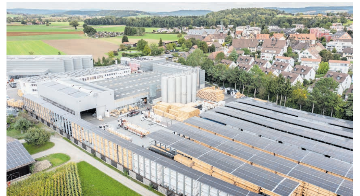
Die mit EKZ Solar Business umgesetzte Solaranlage des Kunststoffherstellers Streng Plastic in Niederhasli (ZH). Die Solaranlage läuft im EKZ-Contracting-Modell. Bild EKZ
